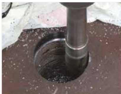
▲ Vergrößern einer Bohrung.
