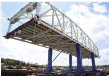
Stufenweiser Brückenhub
