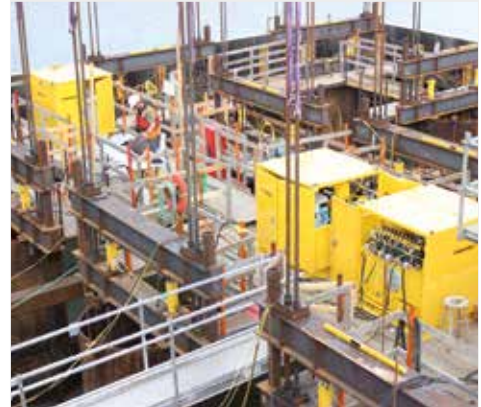
▲ Maßgeschneiderte Hydraulikpumpe für ein Brückenvorschubsystem.
