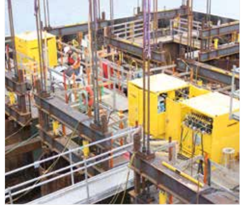
▲ Erikoishydraulipumppu siltakannen rakennusjärjestelmää varten.
